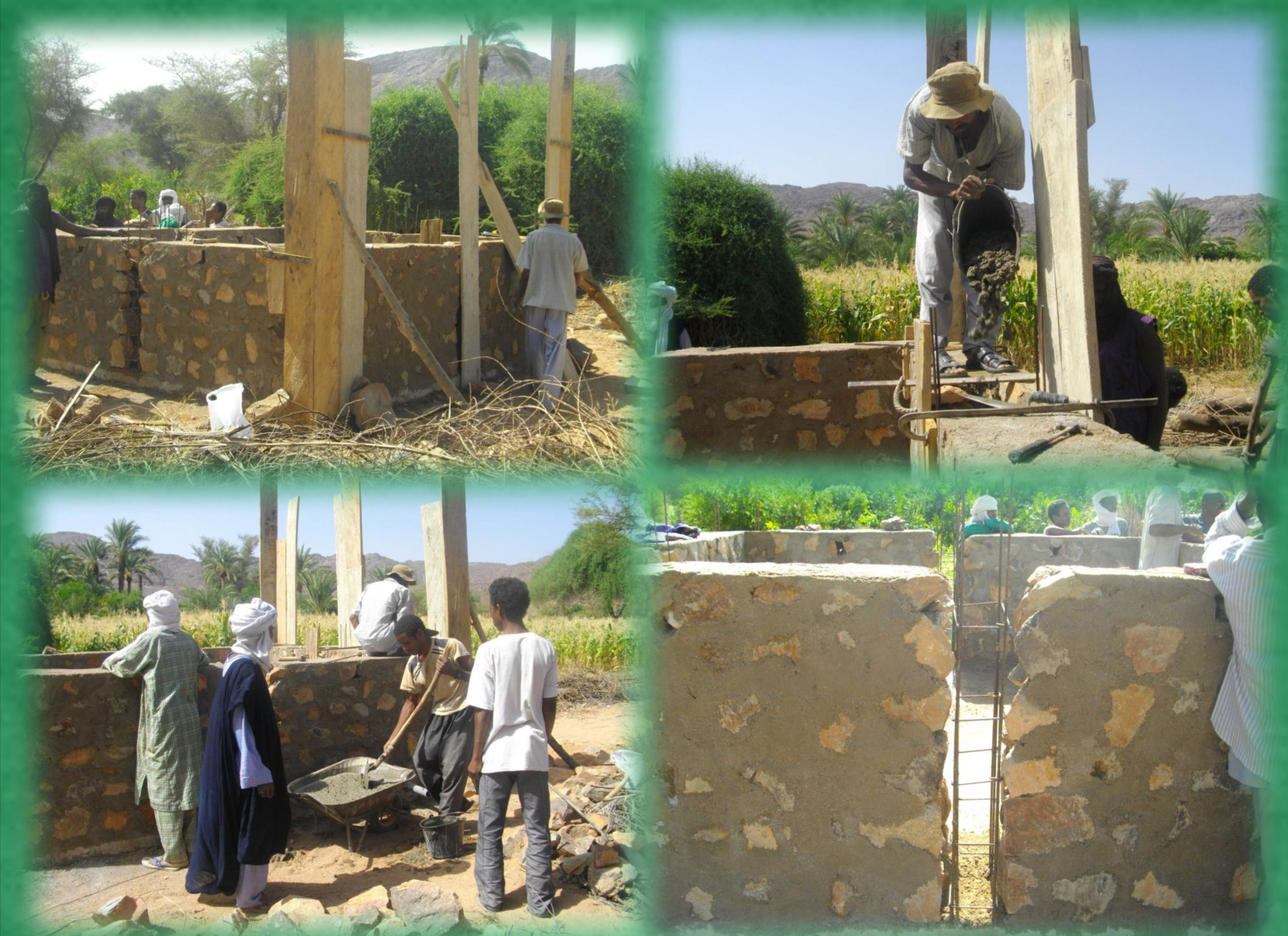
Costruzione del bacino di raccolta acque ad uso agricolo
