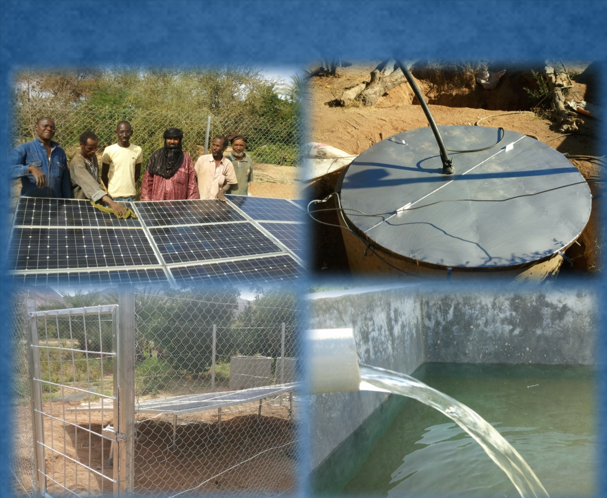
I lavori di installazione dell'impianto irriguo fotovoltaico
